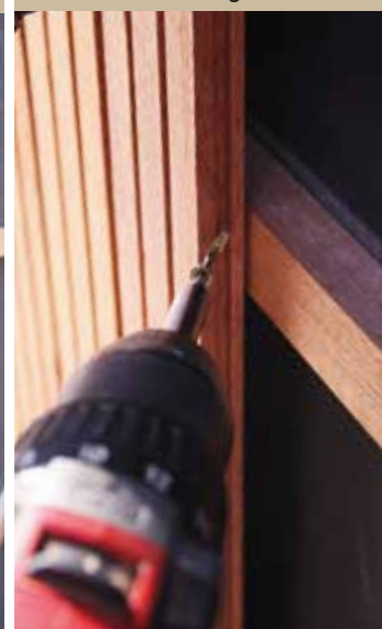
Avvitare con un angolo di 45°
